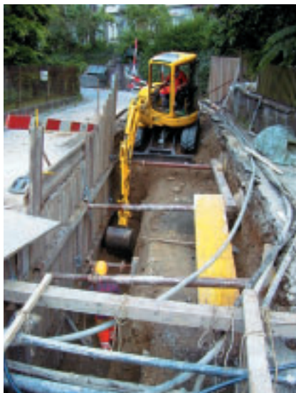
Von Bauunternehmen wird stets Flexibilität gefordert. Ob es sich hierbei um kleine enge Tiefbaustellen ...
