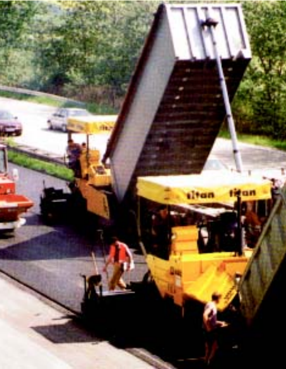
A1 - Hasselburger Mühle Gestaffelter Splitmastixeinbau
